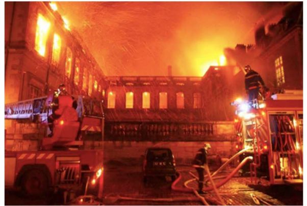
Intervention des pompiers à l'occasion de l'incendie du château de Lunéville (Meurthe-et-Moselle), 2003. © A. Marchi
