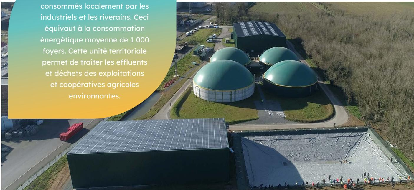
Injection de biométhane d'un débit de 175 m<sup>3</sup>/h
