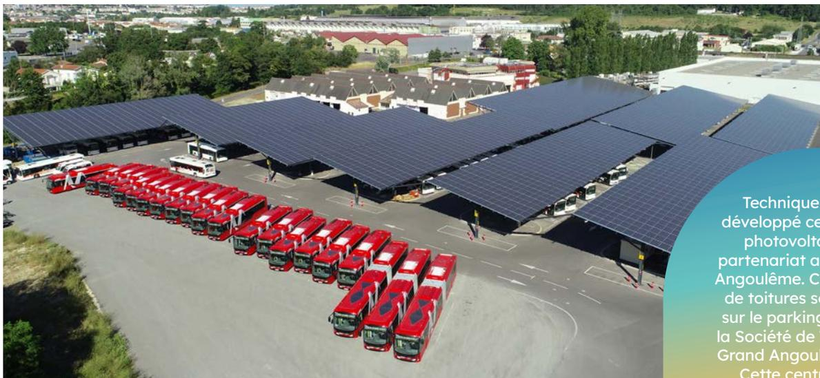
Technique Solaire a développé ces ombrières photovoltaïques en partenariat avec le Grand Angoulême. Ces 10 000 m<sup>2</sup> de toitures sont installés sur le parking des bus de la Société de Transport du Grand Angoulême (STGA). Cette centrale a une puissance de 1,9 MWc.
