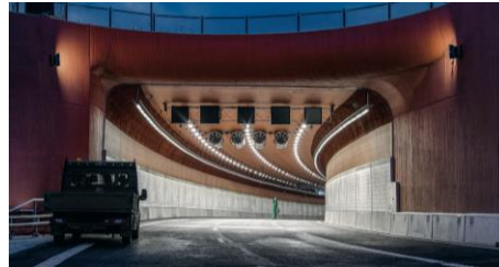
Routes, transports et tunnels
