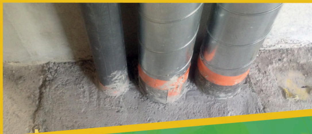
5 Découpe du fond coffrant à l'aide d'une scie cloche / scie sabre au diamètre du futur traversant. Passage de tuyau / gaine à travers le percement réalisé
